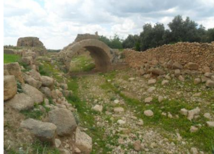
Resim 4: Dara Köprü Kalıntıları (Mayıs-2011)
